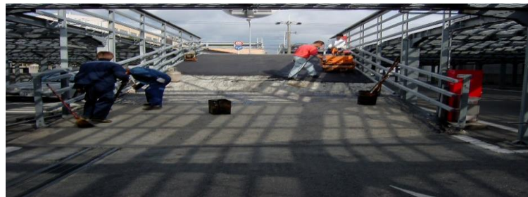
スロープ構造変更工事(パネルからアスファルト(コンクリート)へ)
