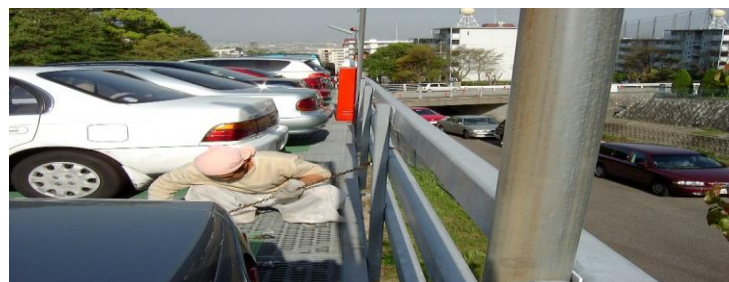
手摺倒れ修正作業
