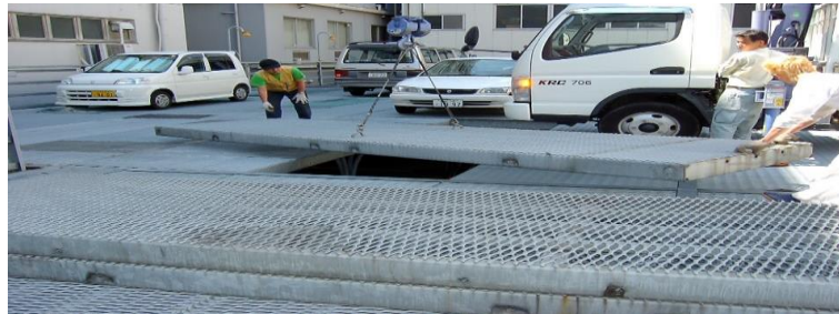
パネル交換作業
